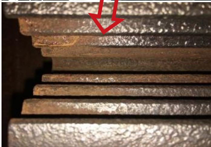
磨损及腐蚀严重
